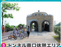
5 トンネル南口休憩エリア
